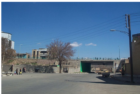
پل خیابان فردوسی سنندج
